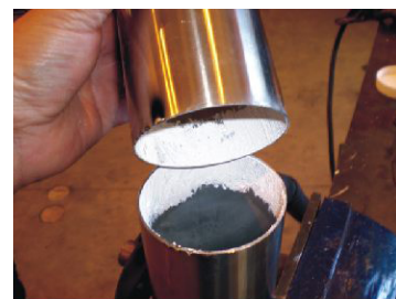
Aplicación en interior de unión a soldar
